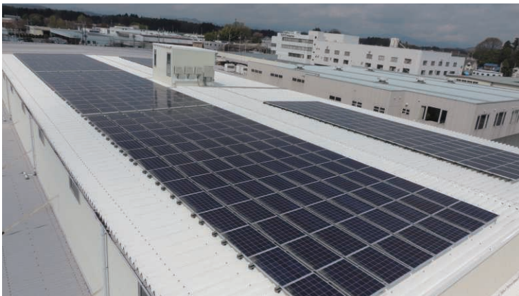
太陽光発電施設(当社、鹿沼物流センター)
